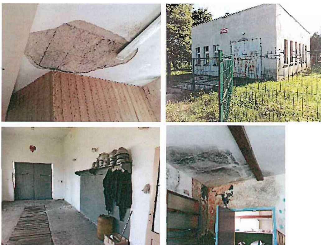
Zdjęcie 2. Budynek OSP w Dąbrówce Królewskiej
