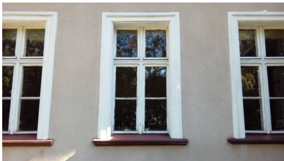
Fot. Nr 1 Widok stalarki okiennej
