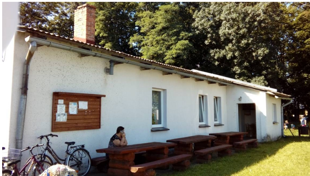
Fot. Nr 2 Świetlica wiejska w Wiktorowie
