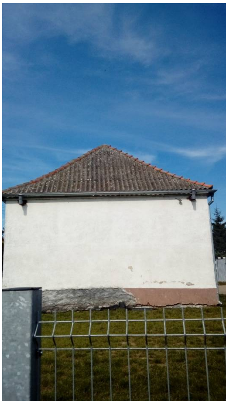
Fot. Nr 2 Fot. ilustrująca kształt dachu
