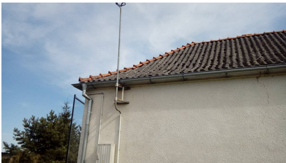
Fot. Nr 1 Fot. ilustrująca kształt dachu
