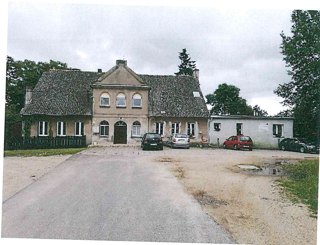
Fot. 1 Obiekt Żłobek w Nicwałdzie w aktualnej infrastrukturze – elewacja frontowa.
