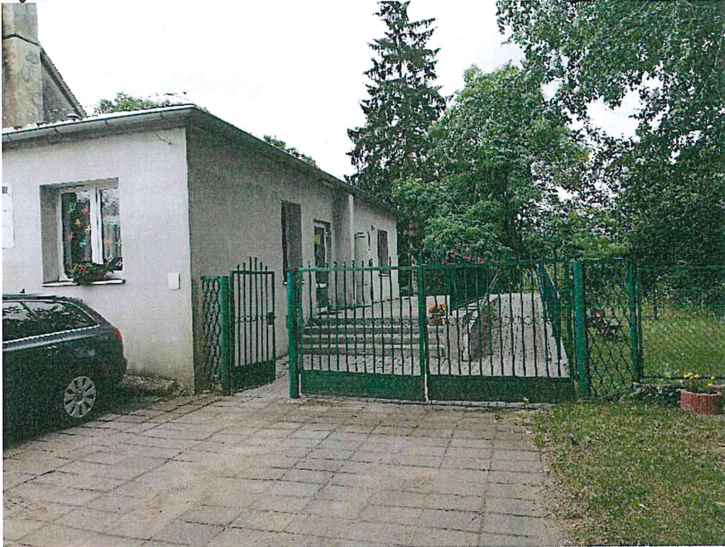
Fot.2 Obiekt Żłobek w Nicwałdzie w aktualnej infrastrukturze – elewacja boczna
