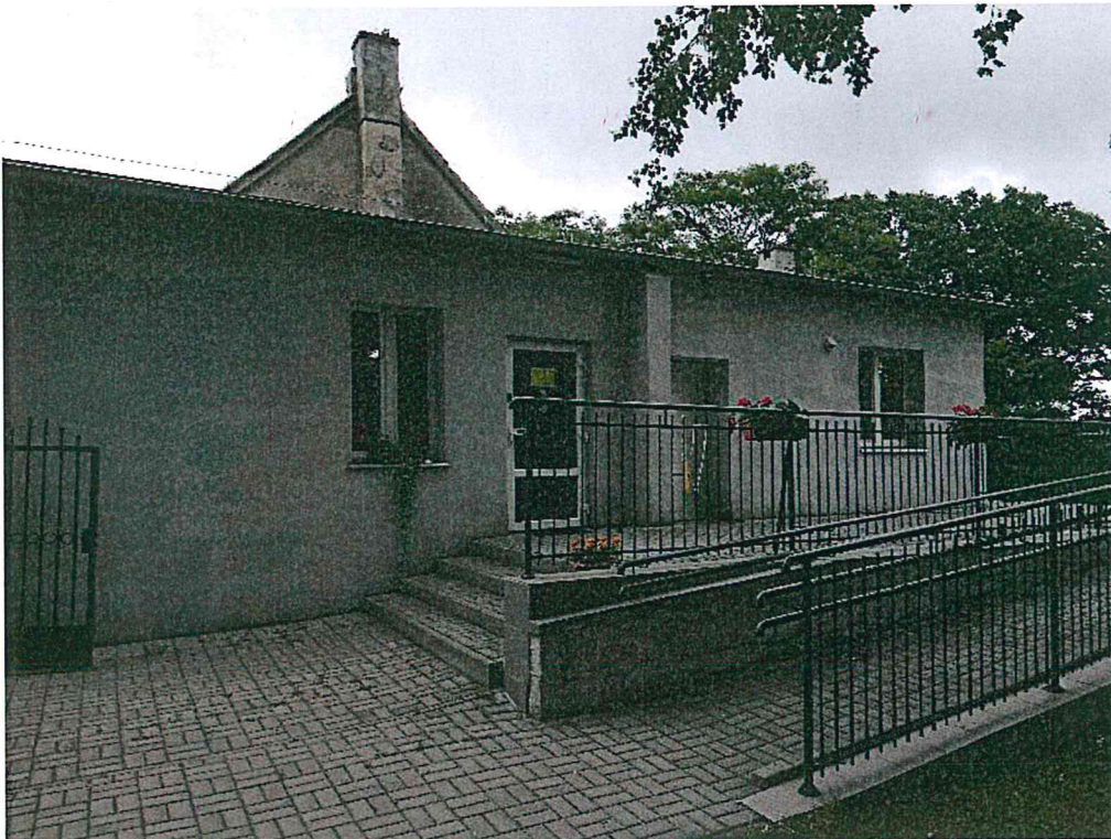
Fot. 3 Obiekt Żłobek w Nicwałdzie w aktualnej infrastrukturze – elewacja boczna
