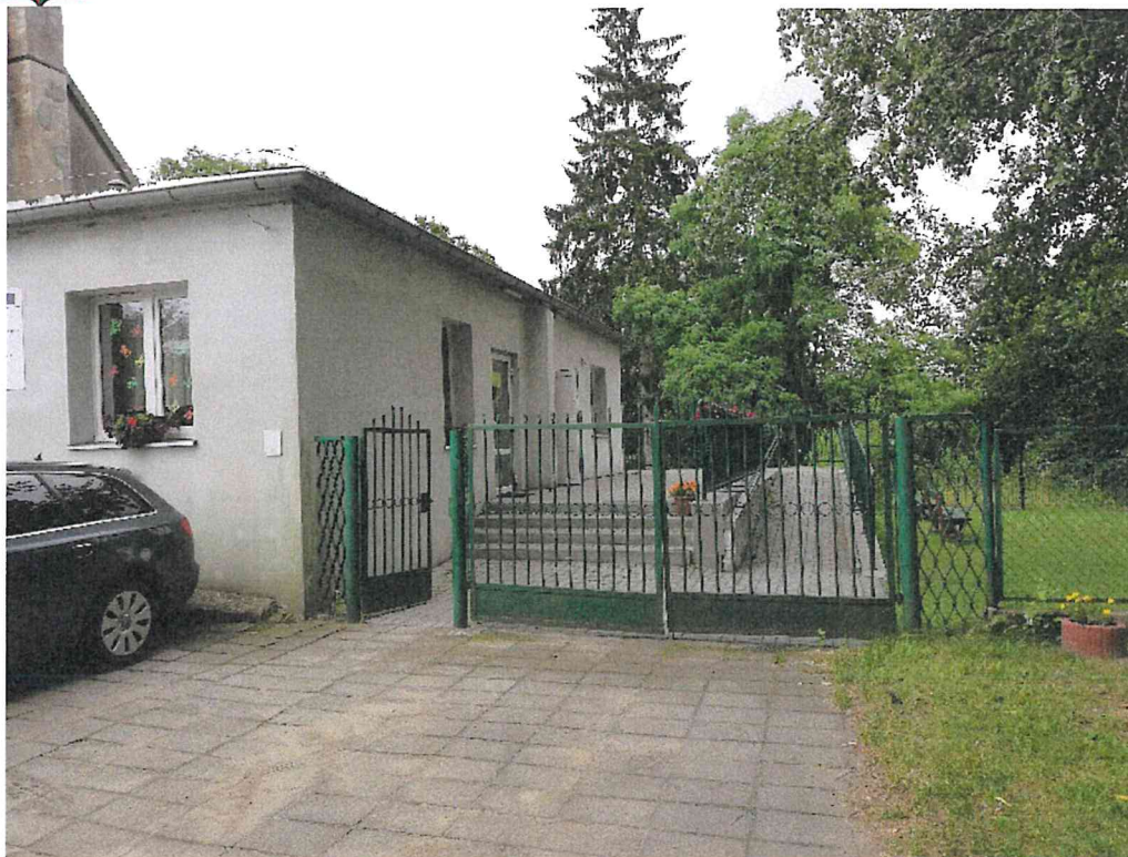
Fot.2 Obiekt Żłobek w Nicwałdzie w aktualnej infrastrukturze – elewacja boczna
