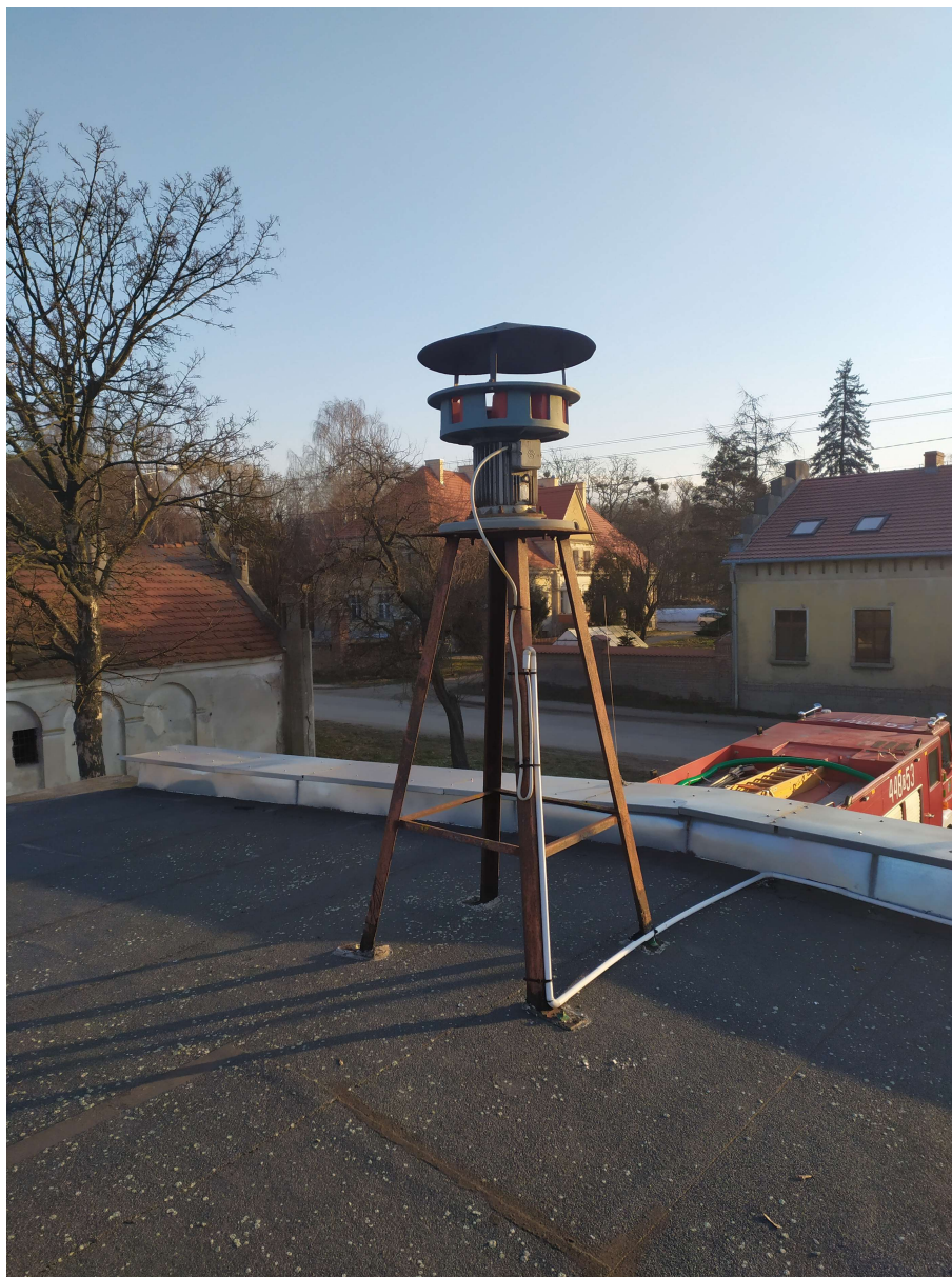
Fot. 3 Widok stan istniejący- syrena na dotychczasowej podkonstrukcji
