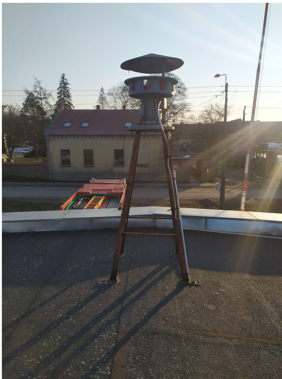
Fot. 4 Widok stan istniejący- syrena na dotychczasowej podkonstrukcji
