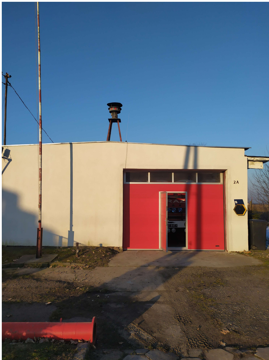
Fot. 1Widok stan istniejący- syrena na budynku OSP
