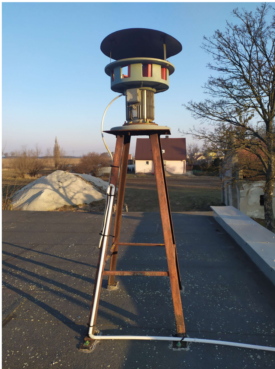
Fot. 2 Widok stan istniejący- syrena na dotychczasowej podkonstrukcji
